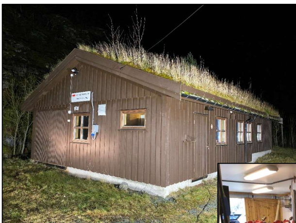
Fig. Hambåra vannbehandlingsanlegg.
