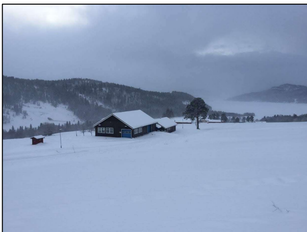
Fig. Songmoen vannbehandlingsanlegg.
